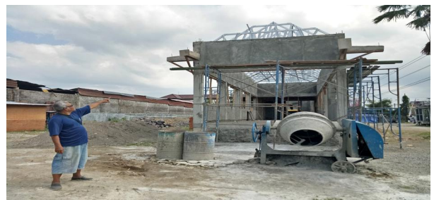
Gambar 6. Tampak samping bangunan
