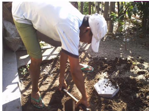
Gambar 8: Lubang Resapan Biopori (LRB) yang Belum Diberi Pralon
