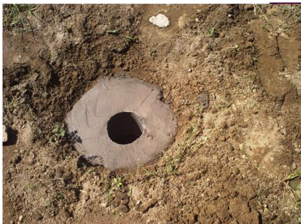
Gambar 10 : Lubang Resapan Biopori (LRB) yang Sudah Diberi Pralon dan Disemen di Sekelilingnya
