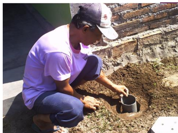
Gambar 9: Lubang Resapan Biopori (LRB) yang Sedang Diberi Pralon
