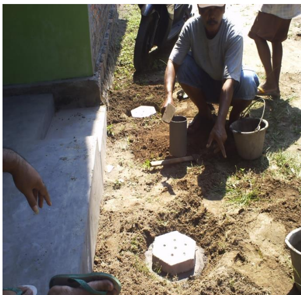
Gambar 11 : Lubang Resapan Biopori (LRB) Sudah Jadi dan Diberi Tutup. Sumber: Dokumen Pribadi
